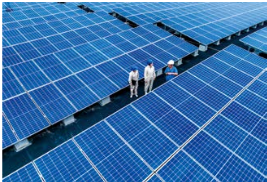
国网昆山市供电公司工作人员核查企业屋顶光伏板覆尘情况
