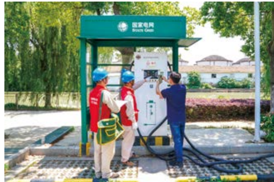
国网昆山市供电公司员工开展充电桩安全用电检查
